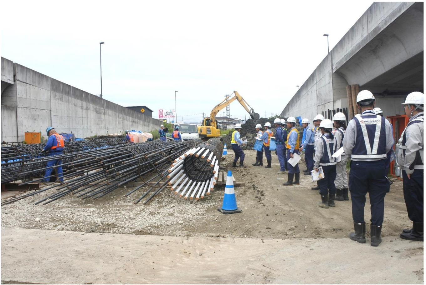
沈殿を待つ間に、「鉄筋かご」と呼ばれる杭の鉄筋部分を見学しました。
