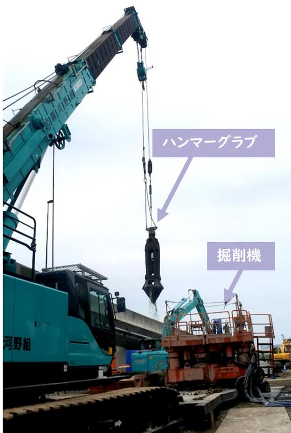
橋脚の基礎には、橋脚の重さを均等に支えるために杭を設置しますが、この杭を設置するために、全回転式の掘削機で、ケーシングチューブという筒型の鋼管を地中に圧入しながら、その内側を下の固い層が確認できるまで掘り進める工法です。
