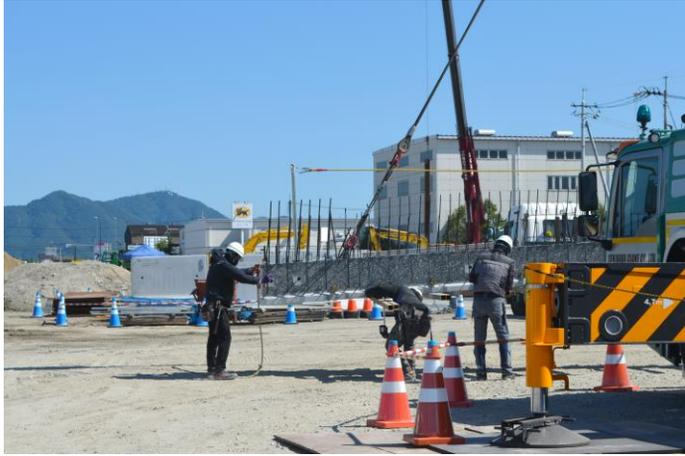
7本目は一度トレーラから降ろして、高所で作業するための足場を取り付けてから設置しています。
