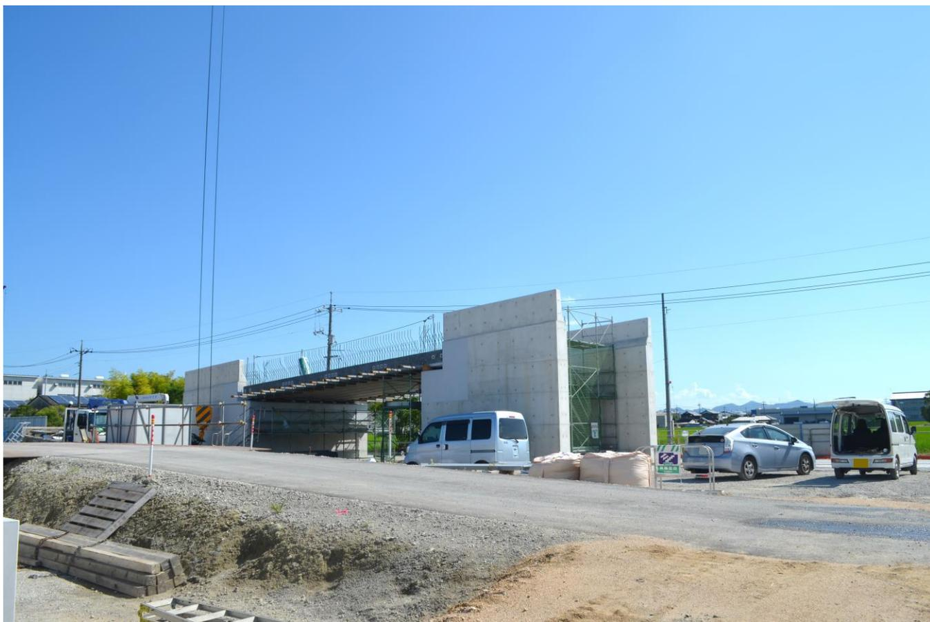
すでに片方の橋梁の桁の設置は完了しており、これからもう一つの橋梁について、全部で8本あるPC桁の5本目を設置します。
