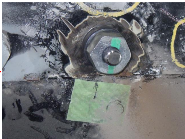
ワンサイドボルトの差し込み・締め付け
