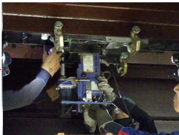
既設のボルト取り壊し
