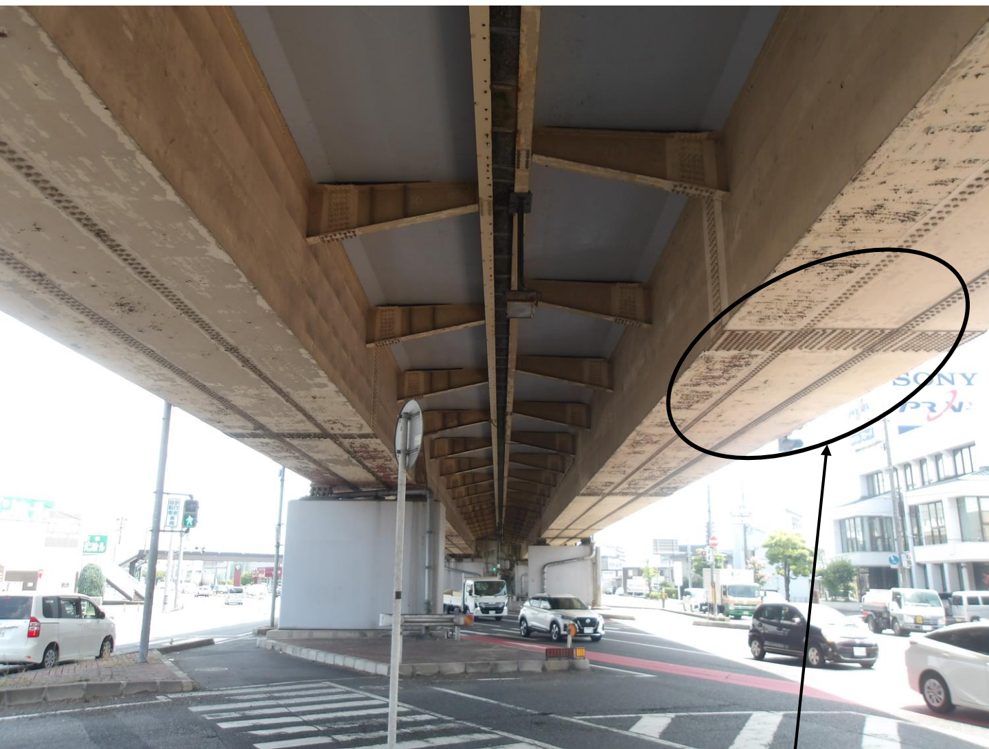
箱桁下からの状況
