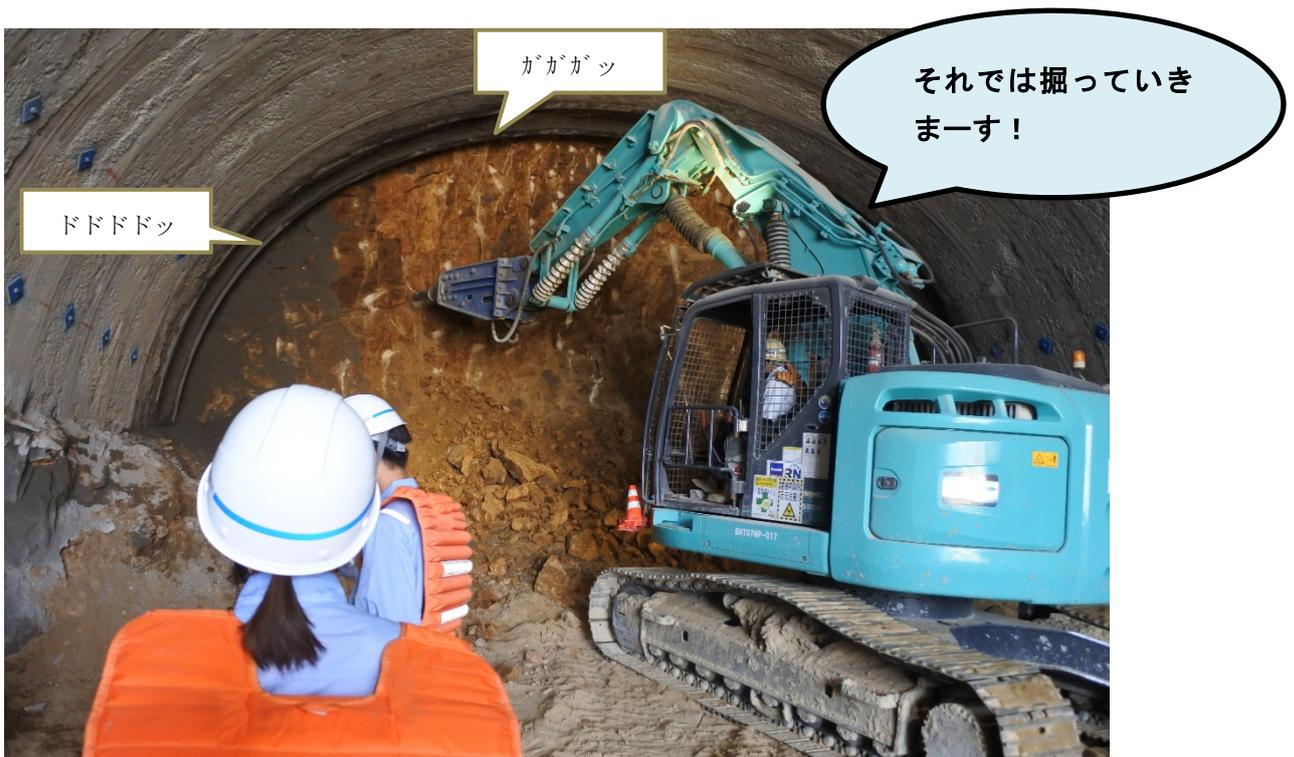
掘削した岩をハンマーで叩いて硬さを確認します。
