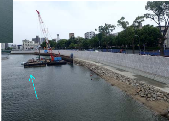
天満川右岸施工状況(広瀬橋下流)
