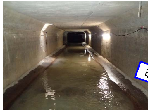
府中1号幹線(施工前)
