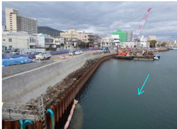
天満川右岸施工状況(広瀬橋上流)
