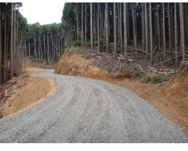
【森林整備：林道（整備）】
