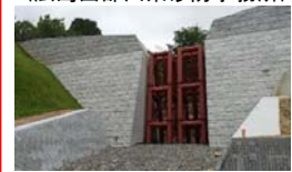
山本1号砂防堰堤 (広島西部山系砂防事務所)
