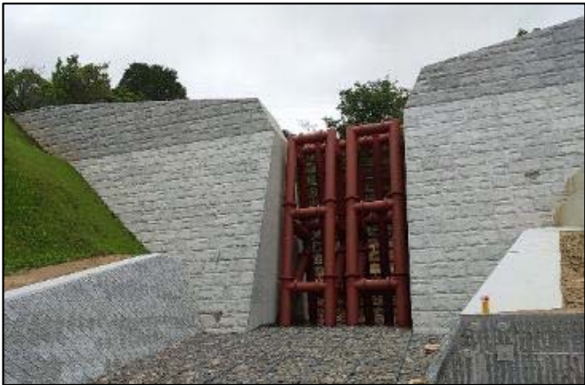
山本1号砂防堰堤（広島市安佐南区）
