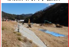
河道掘削 (太田川河川事務所)
