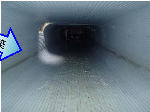
府中1号幹線(施工後)
