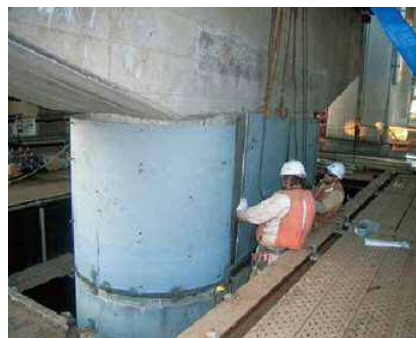
鋼板巻き立てによる補強工事
