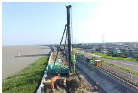
河川堤防の地震対策(木曽川)
