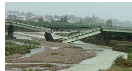
橋梁倒壊(磐越西線)
