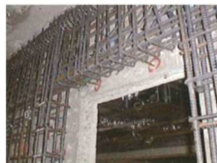
処理場の耐震化躯体補強
