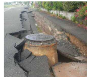
下水道施設（管きよの被災）
