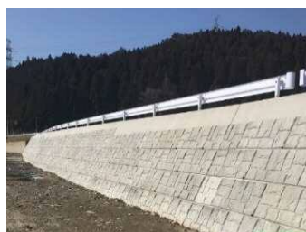
工事完成後の状況(令和3年3月完成)
