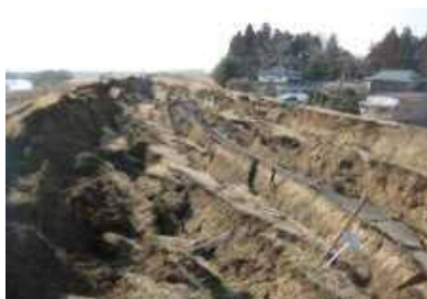
河川堤防の崩壊(鳴瀬川)
