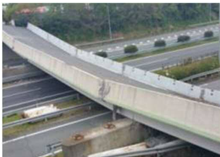
九州自動車道をまたぐロックンブライド橋脚の落橋 (県道小川嘉島線・府領第一橋)
