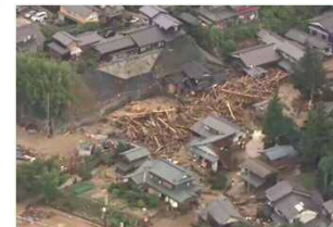
土石流等による被害 (新潟県村上市)
