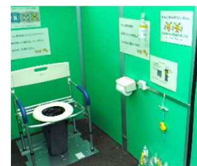
マンホールトイレ
