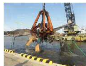
航路啓開(宮古港)
