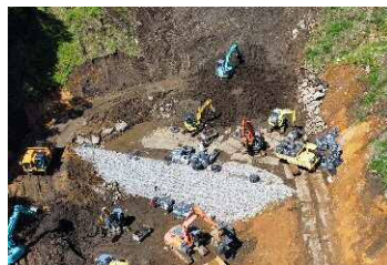
安全対策施工状況
