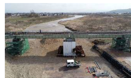
橋梁復旧(磐越西線)
