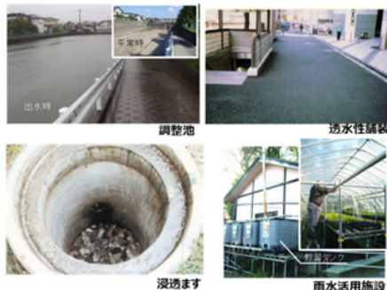
雨水貯留浸透施設の例
