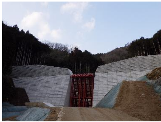
上畠1号砂防堰堤(広島市安佐北区)
