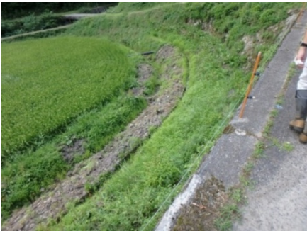
田んぼ法面の掘り起こし状況 (安芸太田町より提供)
