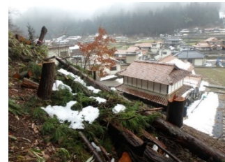
家屋の裏の危険木伐採状況 (安芸太田町より提供)
