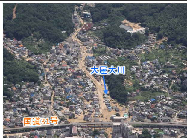
平成30年7月豪雨による被災直後の 呉市天応地区(大屋大川)
