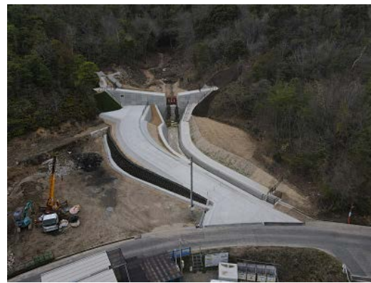
山本6号砂防堰堤(広島市安佐南区)
