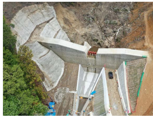
戸坂新町南2号砂防堰堤(広島市東区)
