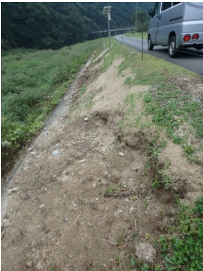
土居河川堤防法面の掘り起こし状況 (安芸太田町より提供)
