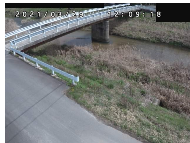
河川カメラの画像(関川・志和町)
