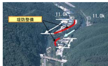
堤防整備(太田川河川事務所)
