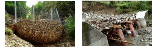
(参考)ワイヤーネットやスリットダムによる土石や流木の捕捉
