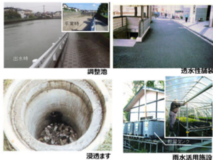
雨水貯留浸透施設の例
