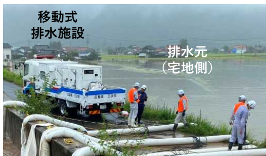
樋管のゲートにポンプを設置
