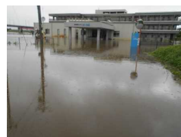
浸水時の状況 (喜多方市提供)
