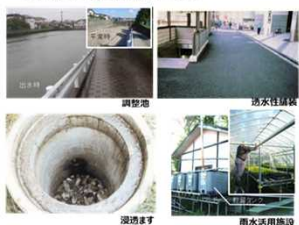
雨水貯留浸透施設の例
