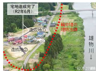
移転先宅地造成完了状況
