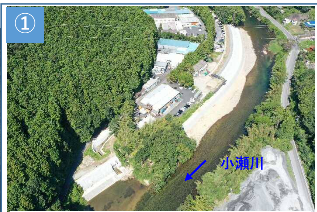
小川津地区堤防施工状況（令和5年9月撮影）
