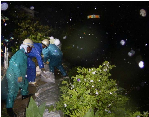
過去の水防状況(土嚢設置)
