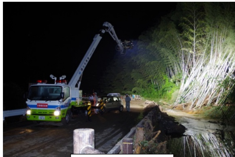
照明車により状況監視
