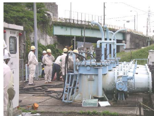
矢口排水機場 合同訓練 平成24年
