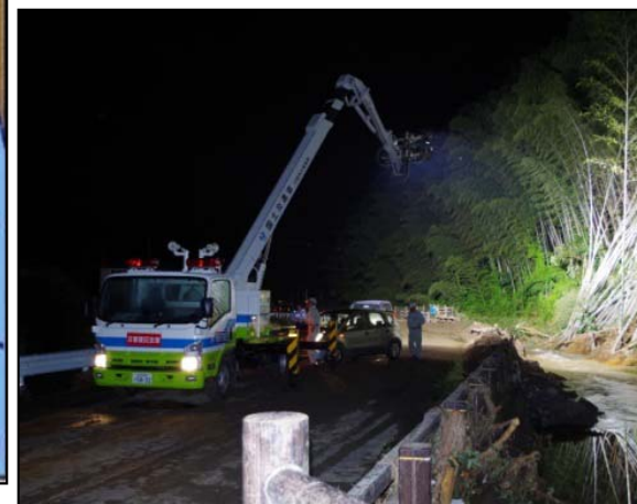
照明車の出動事例
