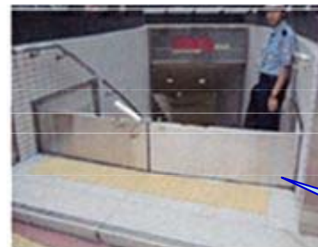
止水板、水防扉の設置
