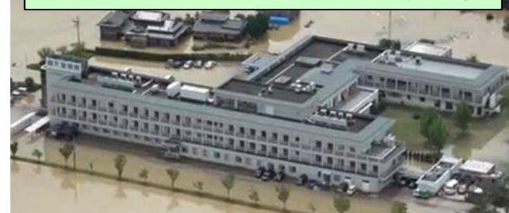
令和元年8月の大雨で浸水した順天堂病院（佐賀県）
