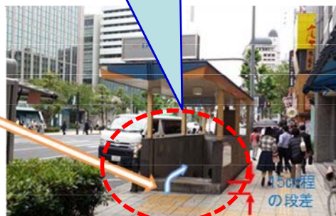
② 浸水シミュレーションにより浸水する出入口の特定と止水板の設置
