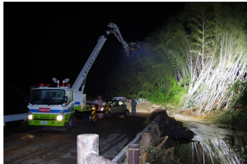
照明車により状況監視
