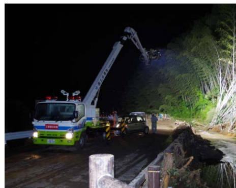
照明車の出動事例
