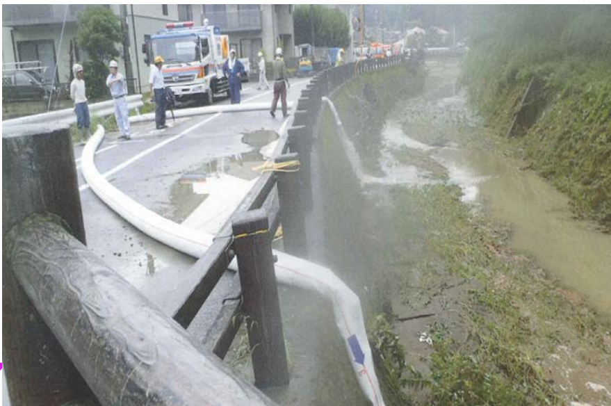
排水ポンプ車による排水作業
