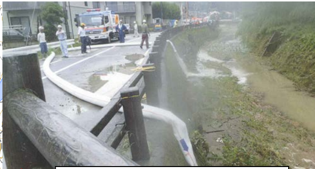
排水ポンプ車による排水作業
