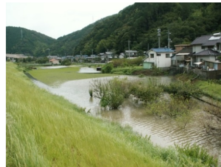
H17.9.6出水(木野2丁目付近)
