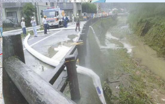
排水ポンプ車による排水作業(平成26年8月6日の事例)
