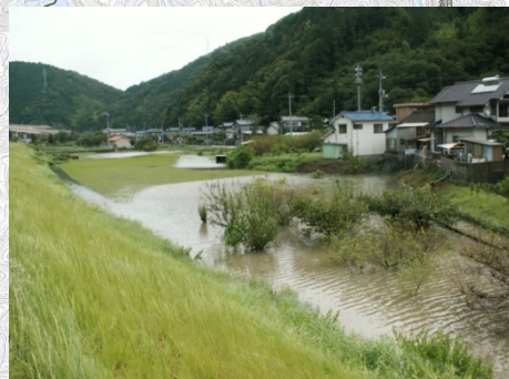
浸水箇所(木野2丁目付近)(平成17年9月出水)
