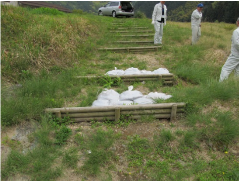
平成26年度巡視状況(土嚢設置)
