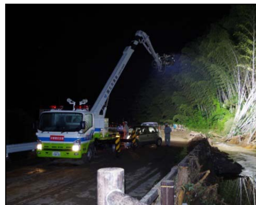
照明車の出動事例
