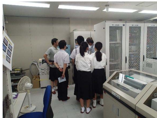
操作室にてダム操作説明
