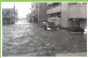
平成16年高潮による浸水状況 (広島市南区出島付近)
