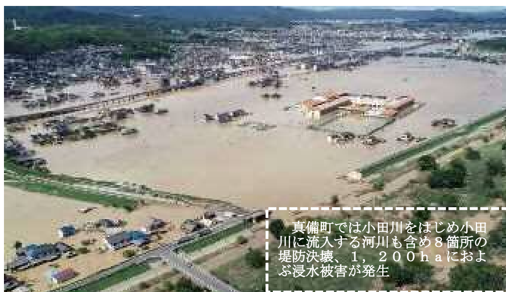
図1-2 平成30年7月豪雨 小田川堤防決壊による浸水状況【岡山県倉敷市真備町】
