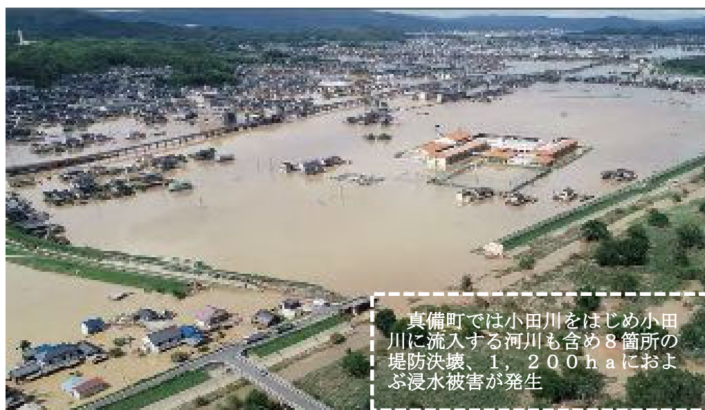
図1-2 平成30年7月豪雨 小田川堤防決壊による浸水状況【岡山県倉敷市真備町】
