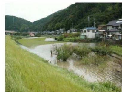
H17.9.6出水(木野2丁目付近)
