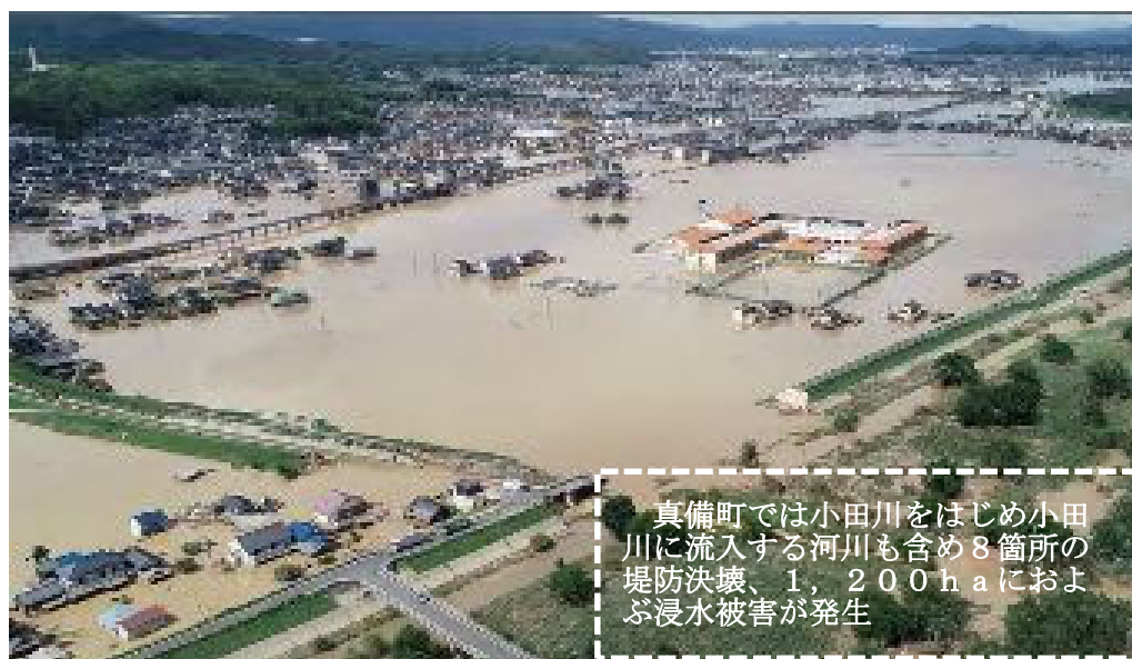
図1-3 平成30年7月豪雨 小田川堤防決壊による浸水状況【岡山県倉敷市真備町】
