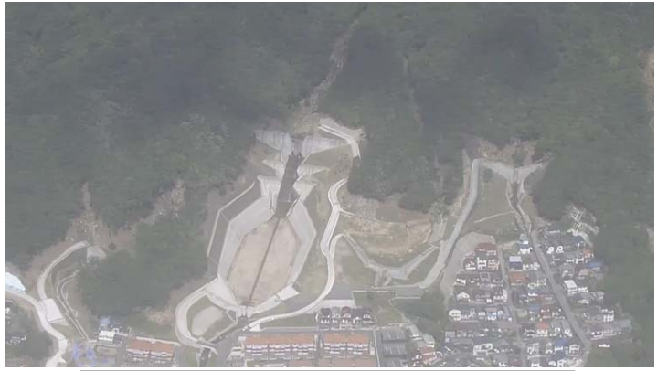
【ヘリ画像】砂防状況(八木地区)
