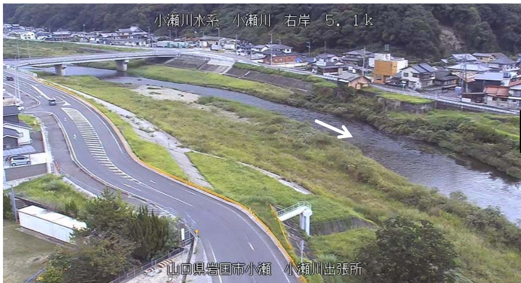
小瀬川水系小瀬川(小瀬川出張所付近) 平常時
