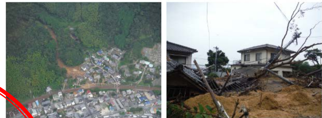
平成26年（2014年）8月6日の豪雨によりがけ崩れが発生
