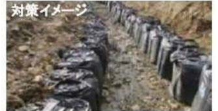
○大型土のうによる流路
