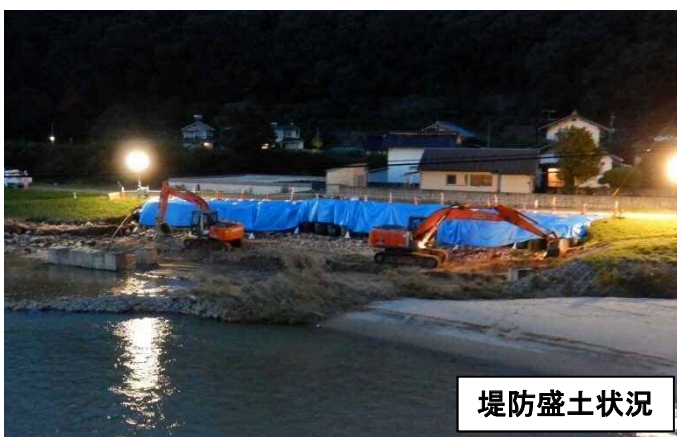
【緊急対策工事内容】
