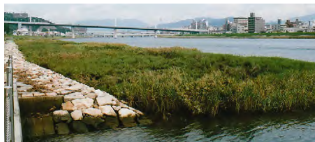
図 2.8.7-2 己斐橋上流側右岸の塩生植物群落。2011 年 9 月。一部にヨシが混在。
