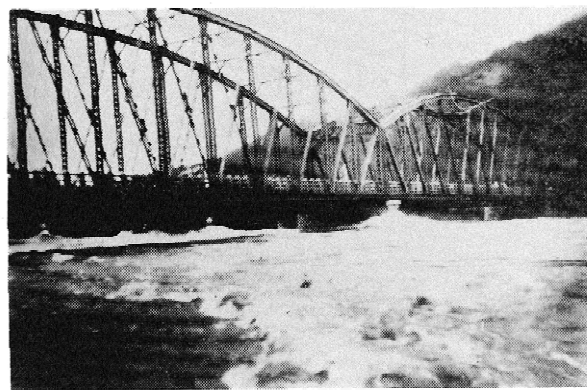
図1.2.1-6 ルース台風による出水状況(太田川橋付近)
