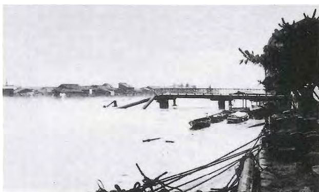
図1.2.1-4 相生橋流出状況(出典:広島市公文書館)
