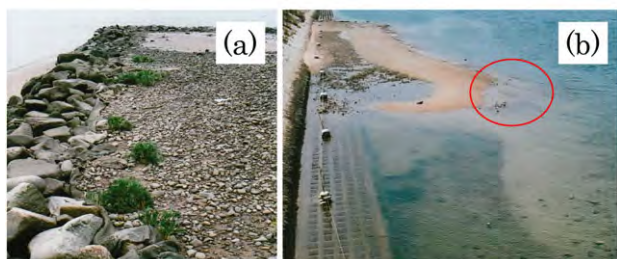
図 2.8.5-4 斜面部分でのフクドの分布の偏り。2011 年に斜面で見られたフクドは、下流側の捨石工沿い (a) と、水路側に張り出している平坦区 1 の斜面 (b の赤丸部分) で、特に多かった。
