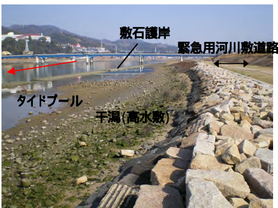
図 3.2-2 太田川放水路左岸の0.2kmより上流区間の敷石護岸と緊急用河川敷道路(1.2km付近左岸)(タイプ3干潟)
