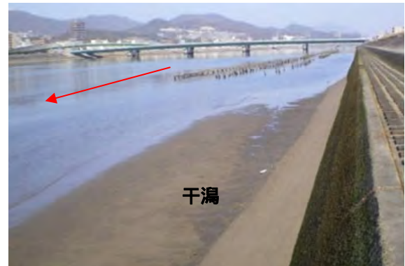
図 2.3.6-6 緊急用河川敷道路の整備が予定されている太田川放水路左岸の 0.2km より下流における干潟（タイプ 2 干潟）
