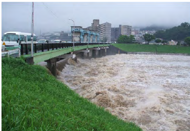
図 1.2.2-5 平成 17 年出水時の大芝水門
