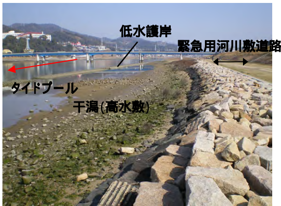
図 2.3.6-5 太田川放水路左岸の 0.2km より上流区間の敷石護岸と緊急用河川敷道路（1.2km 付近左岸）（タイプ 3 干潟）
