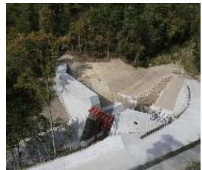
綾ヶ谷1号砂防えん堤
