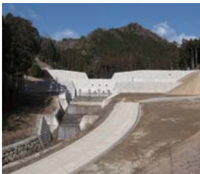
宮内2号砂防えん堤
