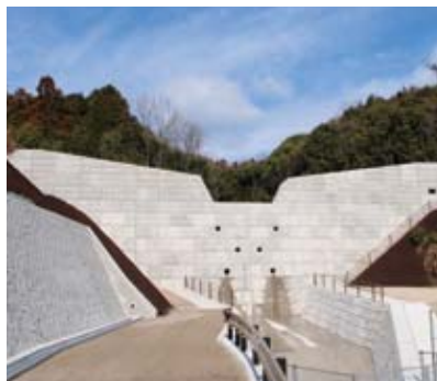
大町3号砂防えん堤
