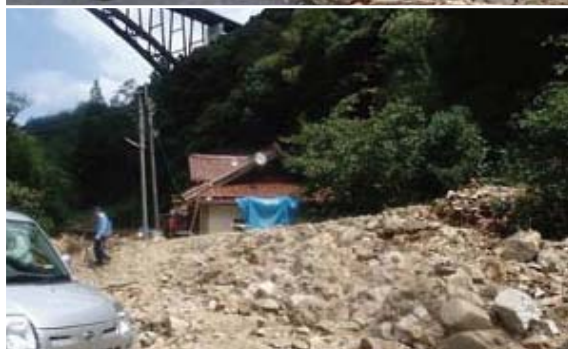
土石流発生箇所の調査(山口県萩市内)
