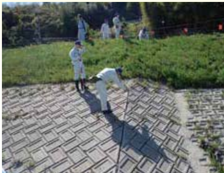
出水期前堤防点検の様子
