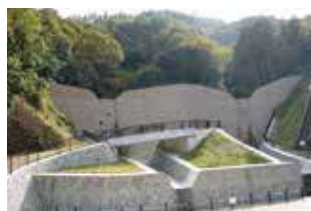
相田1号砂防堰堤(H16.7完成) 広島市安佐南区
