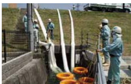
排水ポンプ車操作訓練の様子
