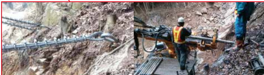
地中の岩盤に18本のアンカーで固定しています
