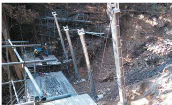
⑨渓流番号:1-9-1005(梅林西沢) 施工中
