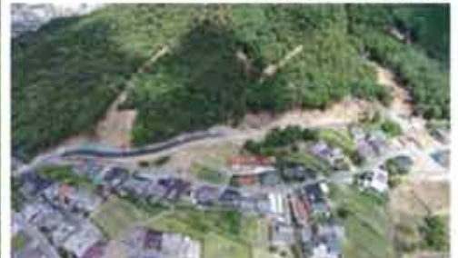
可部東地区工食用進入路
