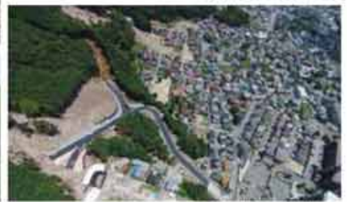
八木4丁目地区工食用進入路
