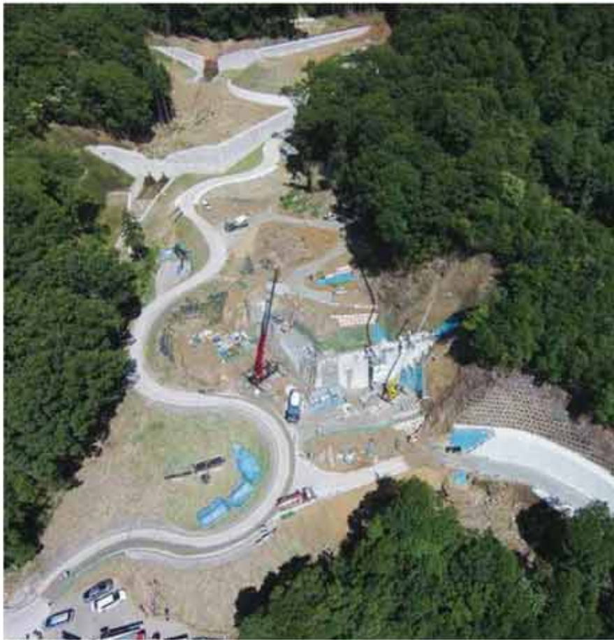
工事中の別所川(1009溪流)砂防えん堤
