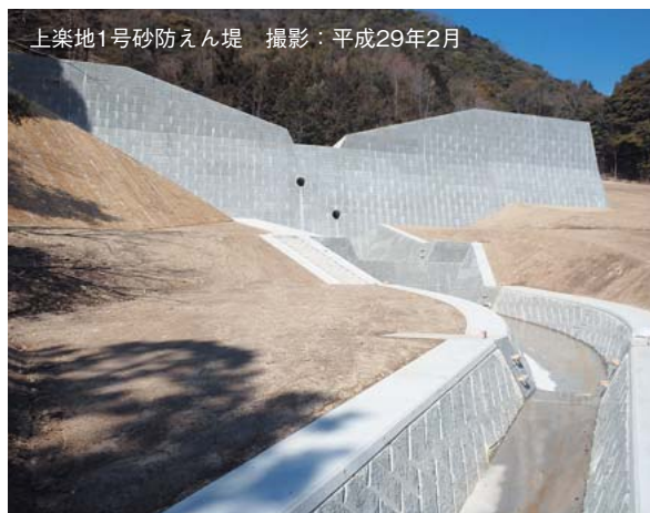
高取地区砂防えん堤 撮影：平成29年2月
