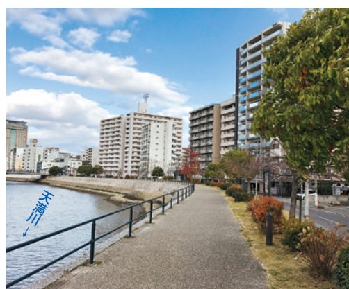
天満川左岸（中区側）整備後の状況（新観音橋上流平成29年撮影）
