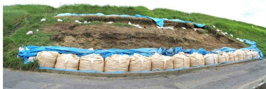
図 3-4-1 堤防のり面の損傷事例（対策済）
