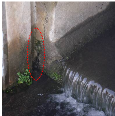
小瀬排水樋門（クラックから漏水）
