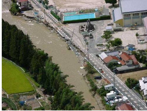
図 3-7-1 H17.9洪水 玖島川の被災状況（広島県廿日市市）
