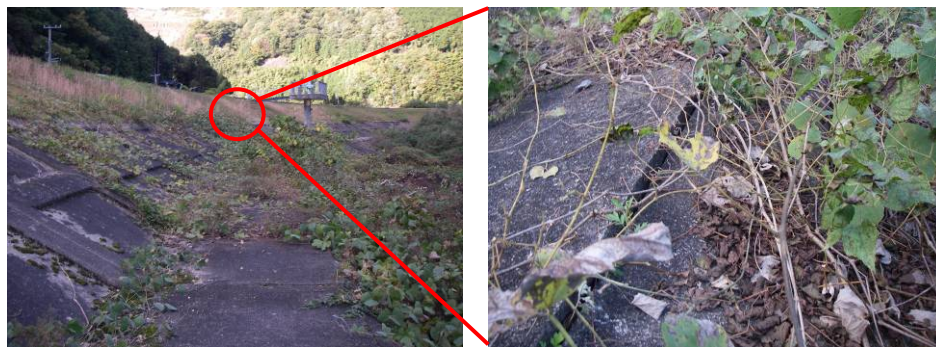
図 3-4-3 取付護岸のずれ (対策済)
