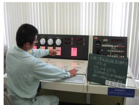
放流警報装置点検状況
