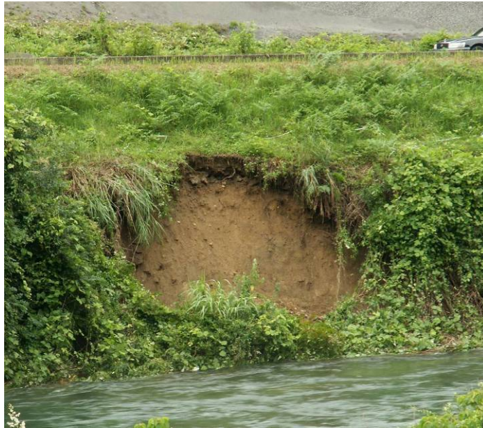
図 3-3-1 洗掘による護岸崩壊（対策済）
