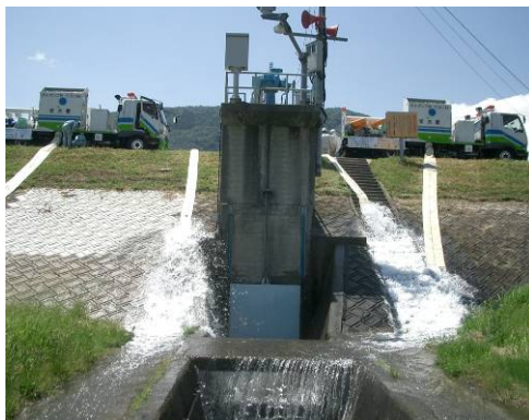
排水ポンプ車操作訓練
