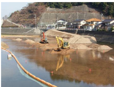
図 5-2-2 H22 中市堰掘削工事
