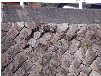
管理区間上流部の空石積護岸
