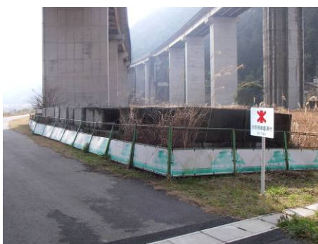
図 5-6-1 水防資材の備蓄
