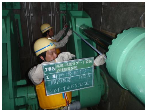
図 5-3-7 機械設備の点検 (中市堰)
