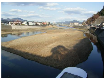
H22 中市堰掘削工事前
