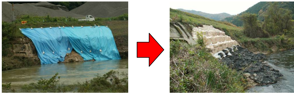
対策前 対策後 図 5-3-2 洗掘により護岸が崩壊した事例（前淵護岸）
