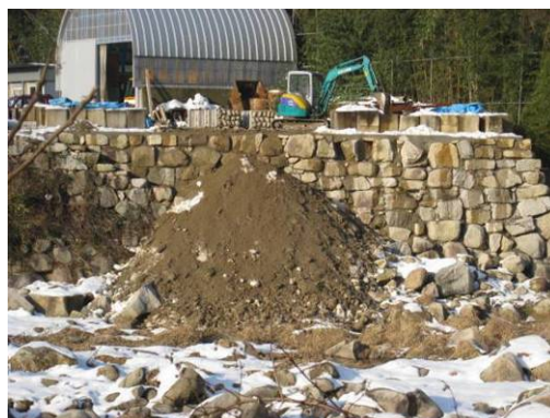
図 5-4-3 河川内への不法盛土の事例 (太田川)
