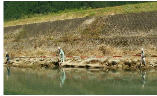
図 6-4-3 出水後の点検
