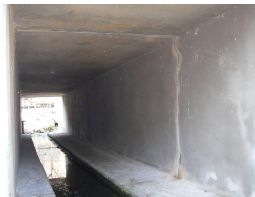
安条排水樋門（函内クラック）
