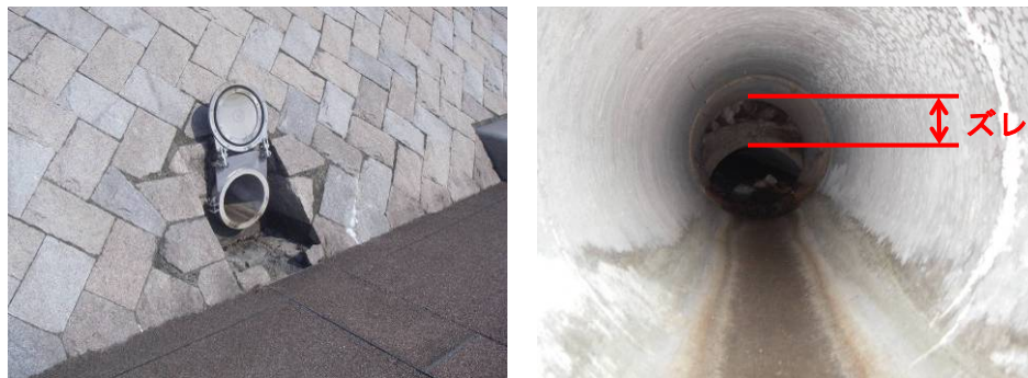
図 3-4-4 樋管のズレ等
