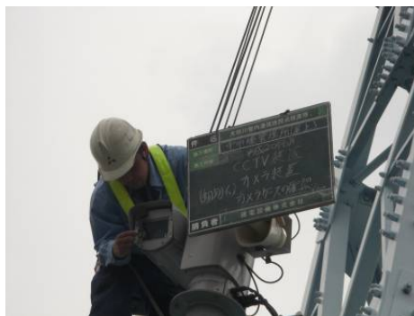
CCTV カメラ点検状況
