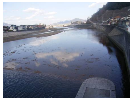
H22 掘削中市堰工事後
