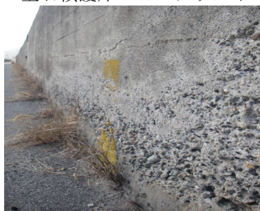
剥離損傷している波返工部材
