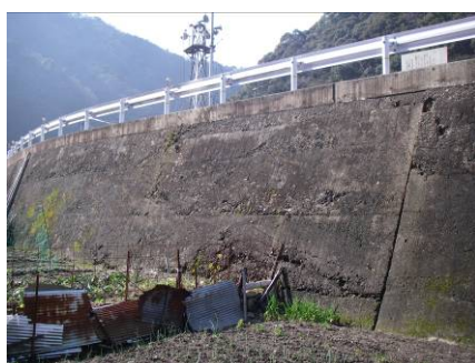
クラックが生じている護岸
