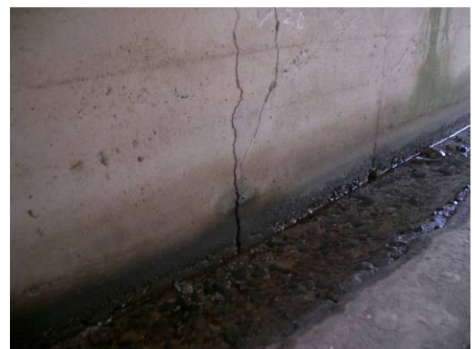
中津原排水樋門（函内クラック）
