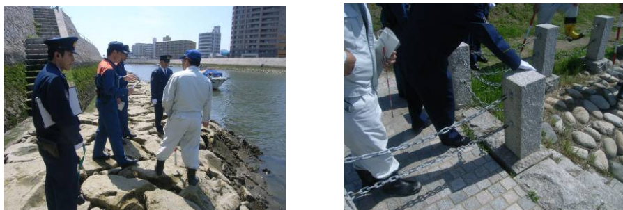
図 6-4-5 親水施設の点検（太田川事例）
