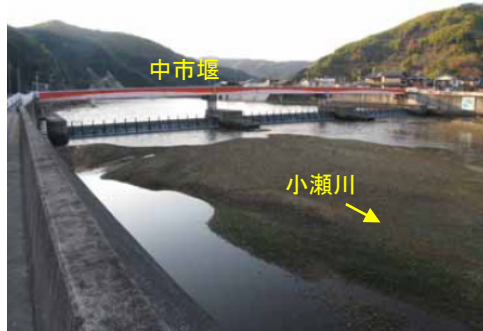
土砂堆積状況 (H22 年 1 月)
