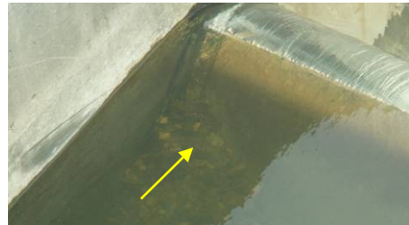
堰上流の堆積状況
