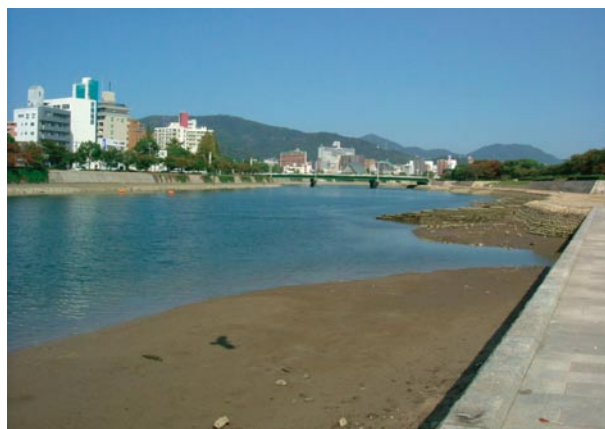
参考資料：橋梁アンダーパス
