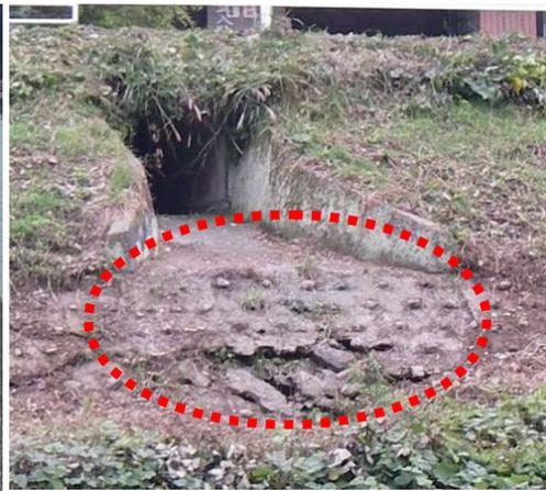
補強コンクリートが剥離している事例
