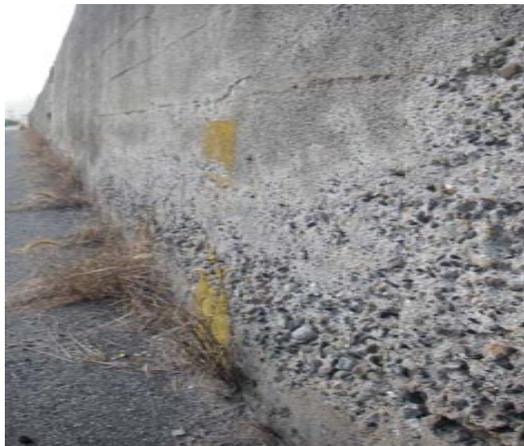
高潮護岸におけるコンクリートの剥離損傷
