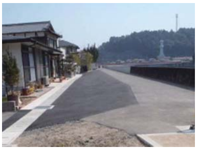
▲堤防天端の補修状況（元町地区）
