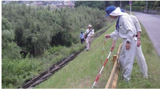
▲堤防点検の実施状況
