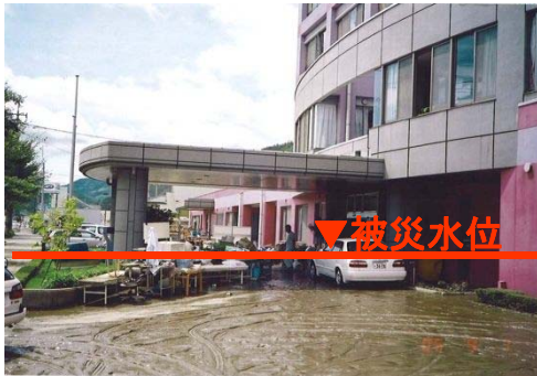
▲④錦川多田地区の病院浸水
