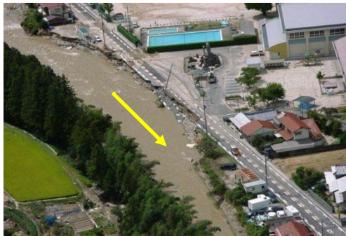
▲①支川玖島川友和地区 河岸洗掘・主要道の崩壊
