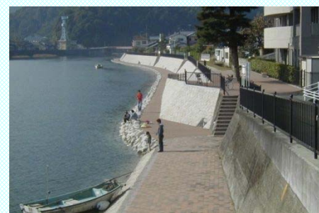
▲大和橋下流左岸(河川管理用通路)
