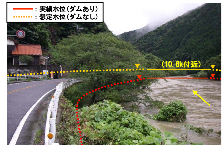
▲危険箇所 比作地区上流(10.8k付近)
