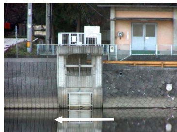
▲和木町農業用水取水樋門 (2k620右岸)
