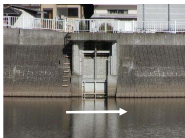
▲大竹市農業用水取水樋門 (2k620左岸)
