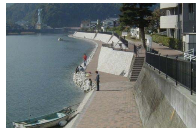
▲大和橋下流左岸（河川管理用通路）
