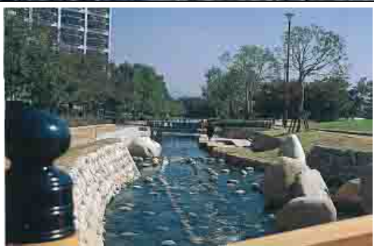
導水路整備状況(せせらぎ河川)
