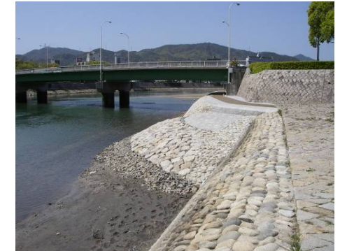
空鞆橋左岸の整備状況
