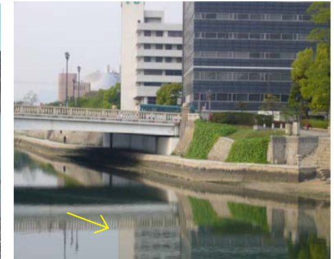
相生橋左岸の整備状況
