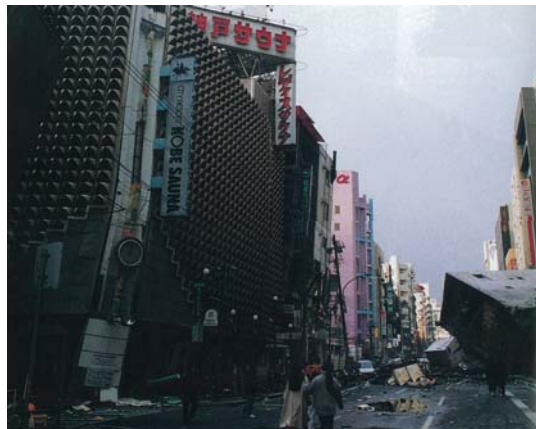
阪神・淡路大震災での被災状況
