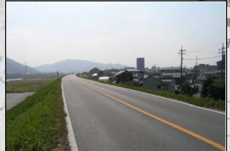
安佐大橋付近右岸(安佐南区側)の様子
