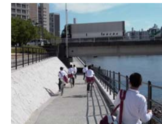
北大橋左岸の利用状況
