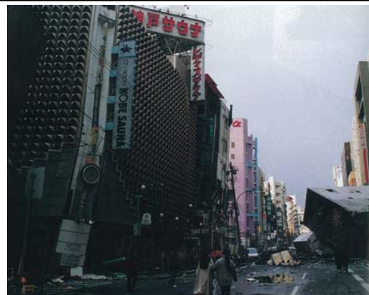
阪神・淡路大震災での被災状況
