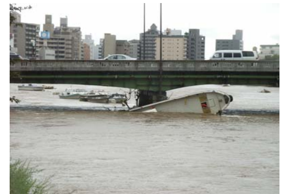
橋脚に引っ掛かったプレジャーボート
