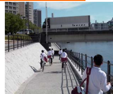
北大橋左岸の利用状況
